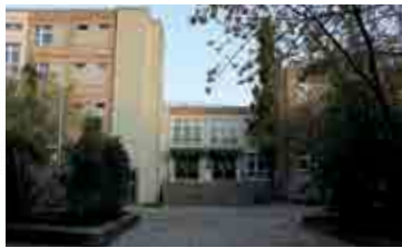
6 GS am Schleipfuhl Sanierung Schulgebäudeteile I und II Verschieben 2025 nach 2027
