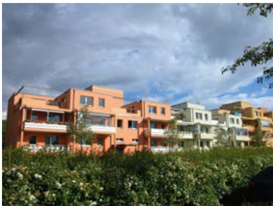
Die Ahrensfelder Terrassen in Marzahn-Nord waren einst elfgeschossige Wohnhäuser. Foto: Rami
