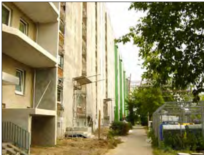
Modernisierungsarbeiten in der Peter-Huchel-Straße.
