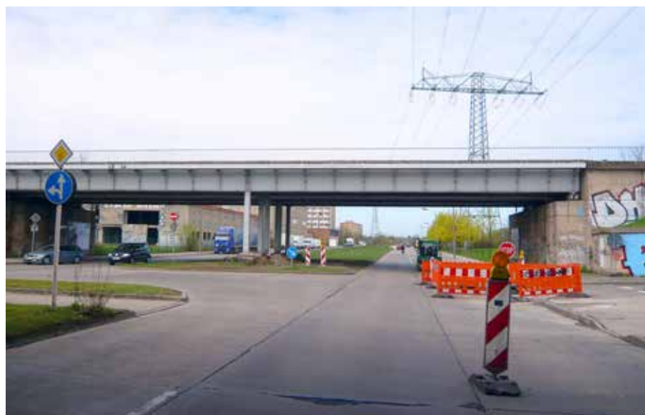
Wie an vielen Stellen in der Stadt: Baustellen engen die Fahrbahnen ein. Einzige Ausnahme hier an der Wuhletalstraße im Bild, dass es gerade mal keinen Stau gibt wie andernorts.
